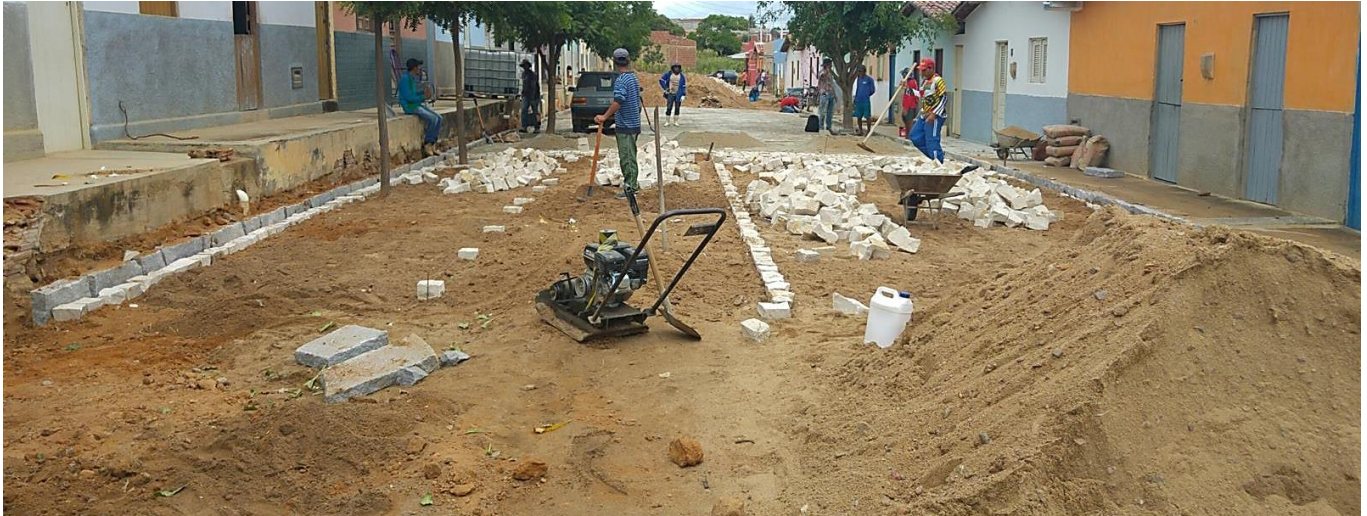
IMAGEM 05: AREIA DEPOSITADA NA RUA A SER PAVIMENTADA QUE SERÁ USADA COMO COLCHÃO DE AREIA
