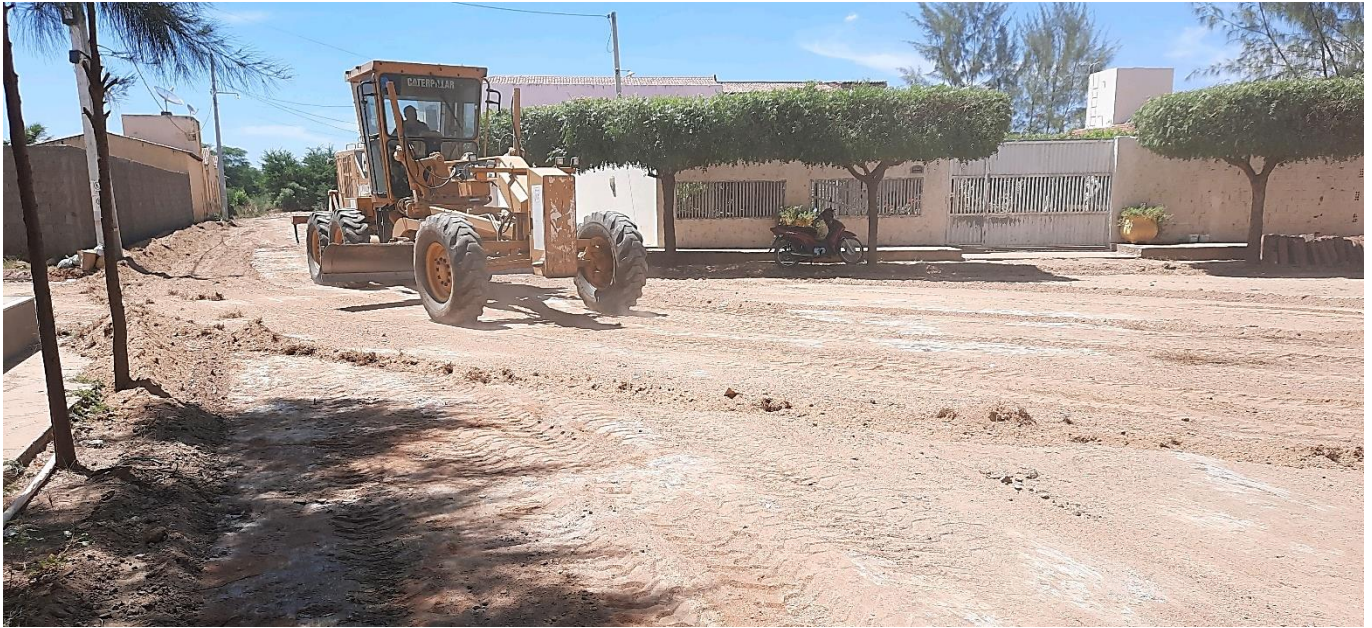
IMAGEM 03: EXECUÇÃO DA TERRAPLANAGEM DE RUA
