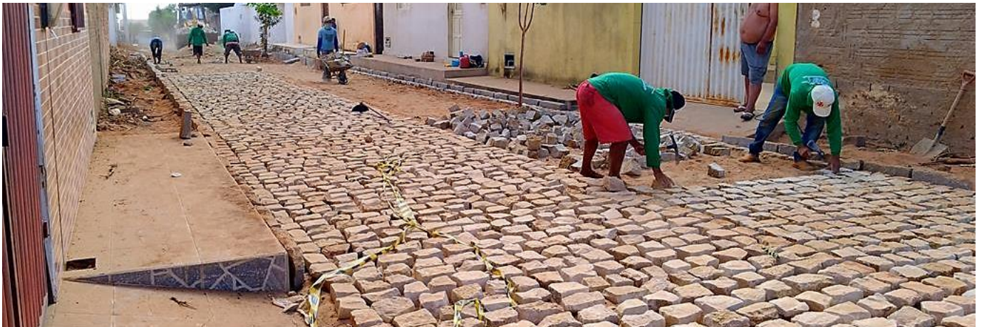
IMAGEM 04: ASSENTAMENTO DE PARALELEPÍPEDOS
