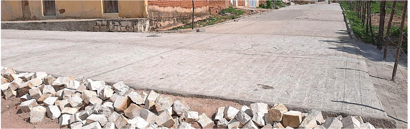
IMAGEM 07: TRAVAMENTO DE FINAL DE RUA COM MEIO FIO
