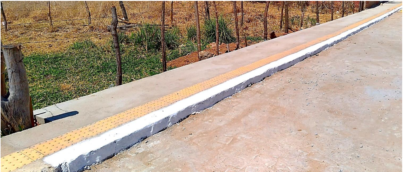
IMAGEM 08: PINTURA DE MEIO FIO.
