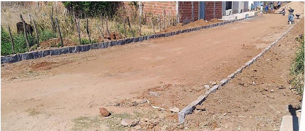
IMAGEM 04: EXECUÇÃO DE MEIO-FIO
