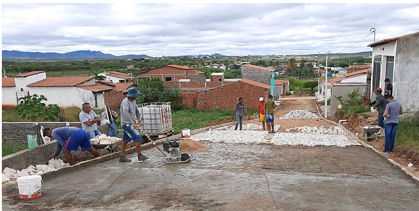
IMAGEM 06: COMPACTAÇÃO MANUAL DO PAVIMENTO
