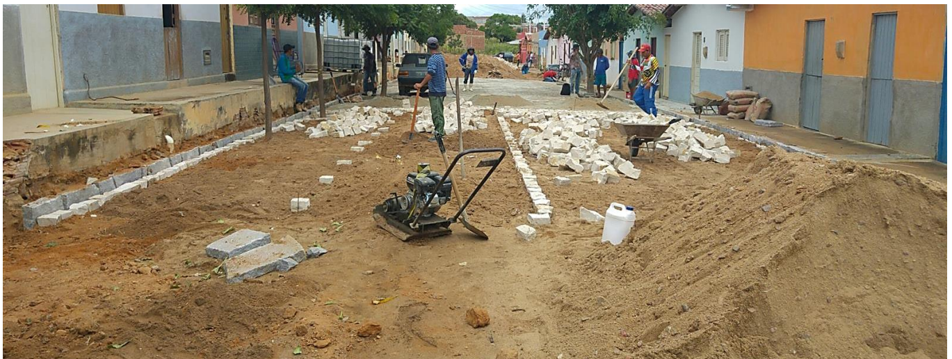
IMAGEM 05: AREIA DEPOSITADA NA RUA A SER PAVIMENTADA QUE SERÁ USADA COMO COLCHÃO DE AREIA
