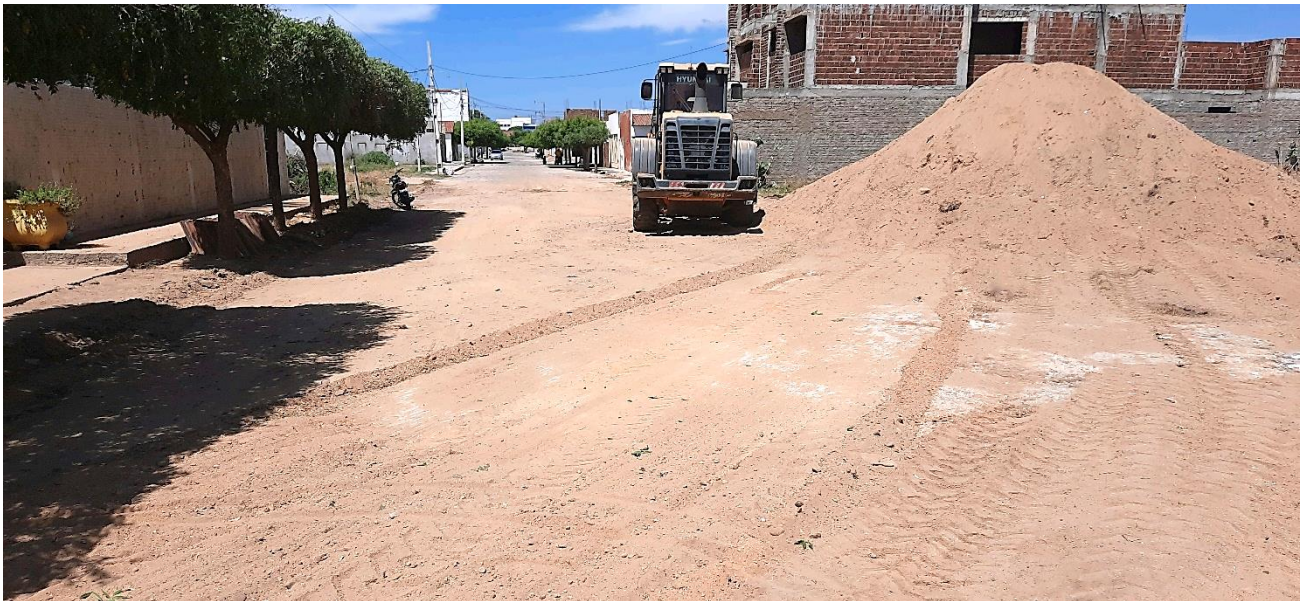
IMAGEM 02: CORTE DE TERRENO
