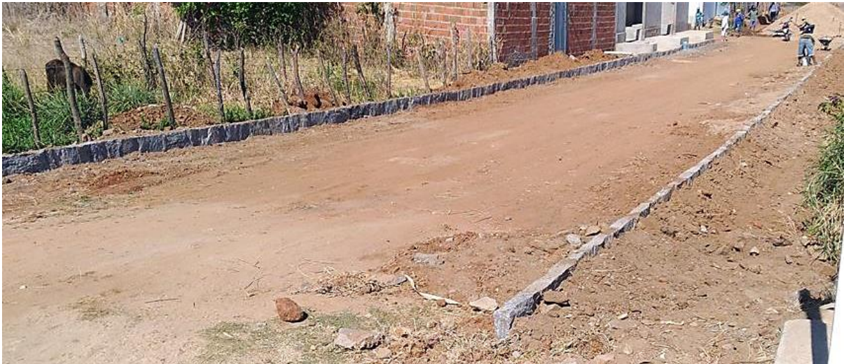
IMAGEM 04: EXECUÇÃO DE MEIO-FIO
