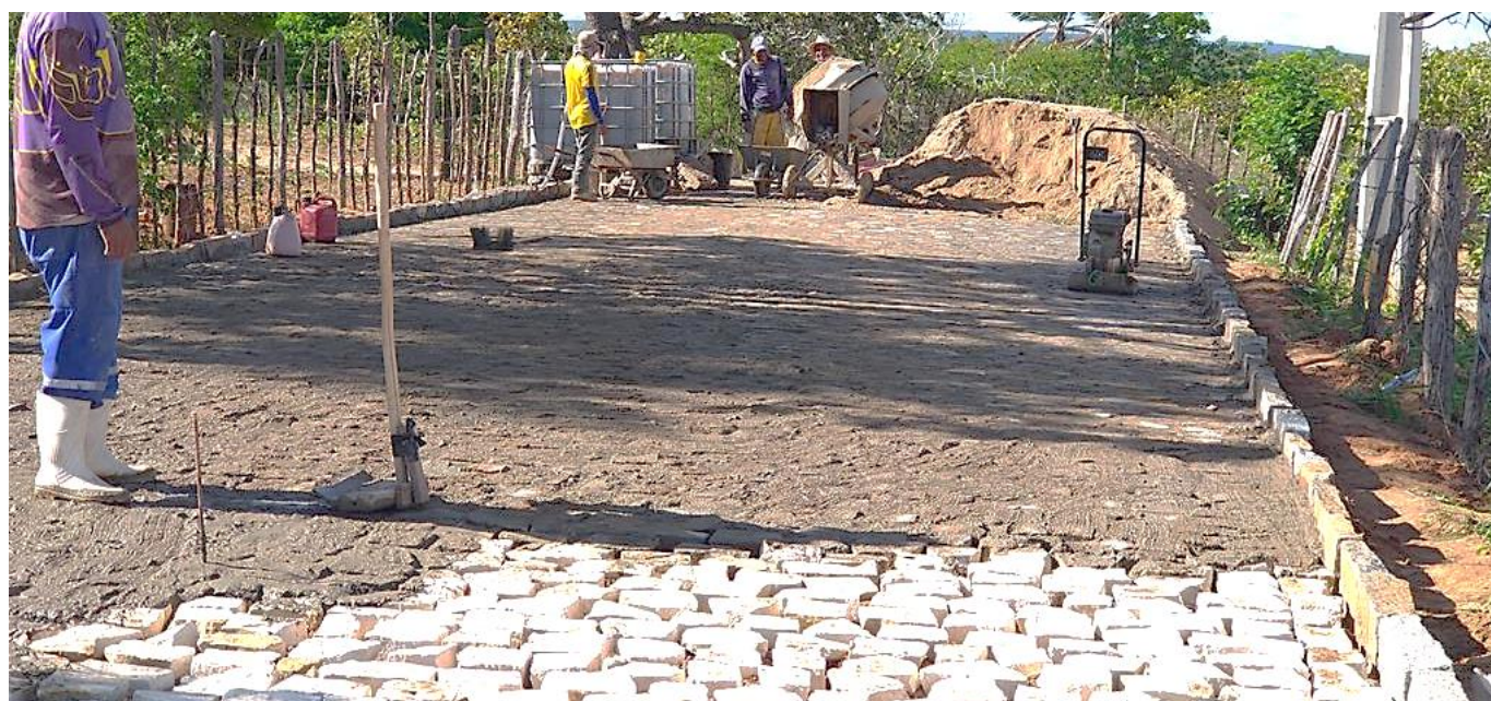
IMAGEM 05: REJUNTAMENTO DE PARALELEPÍPEDOS
