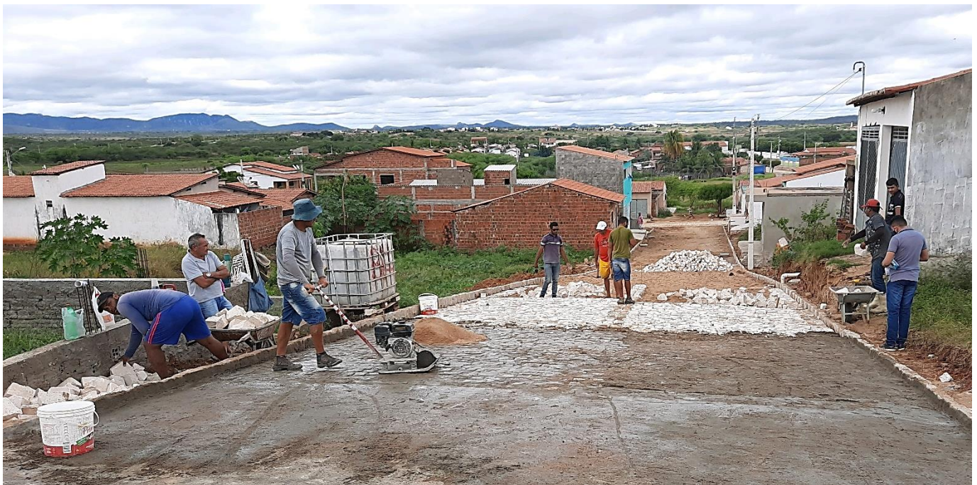
IMAGEM 06: COMPACTAÇÃO MANUAL DO PAVIMENTO
