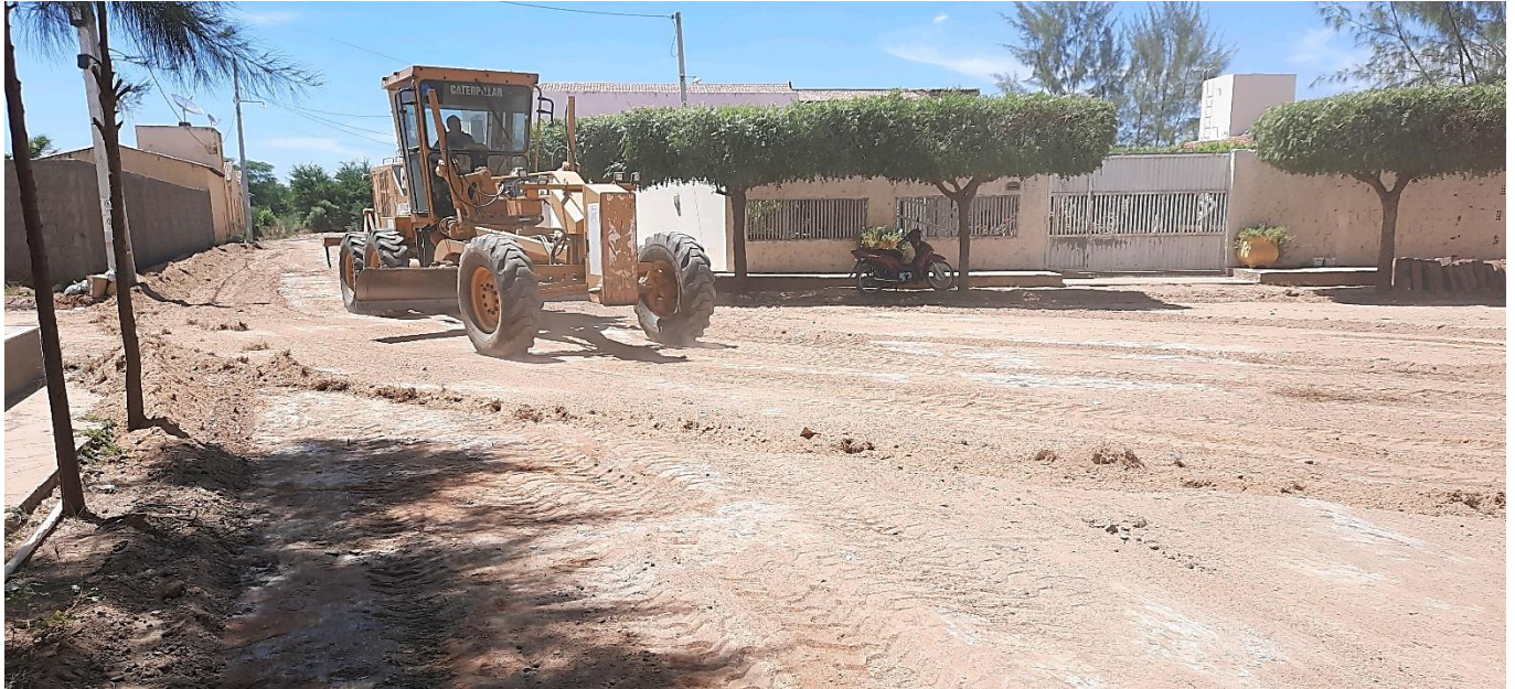
IMAGEM 03: EXECUÇÃO DA TERRAPLANAGEM DE RUA
