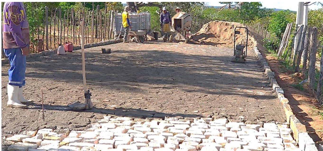
IMAGEM 05: REJUNTAMENTO DE PARALELEPÍPEDOS
