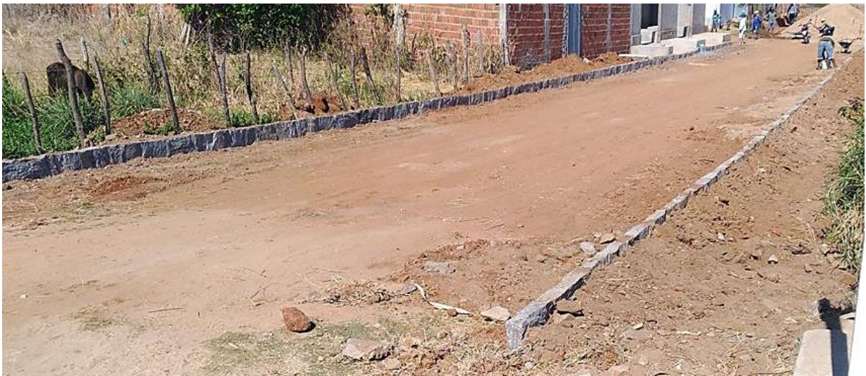
IMAGEM 04: EXECUÇÃO DE MEIO-FIO
