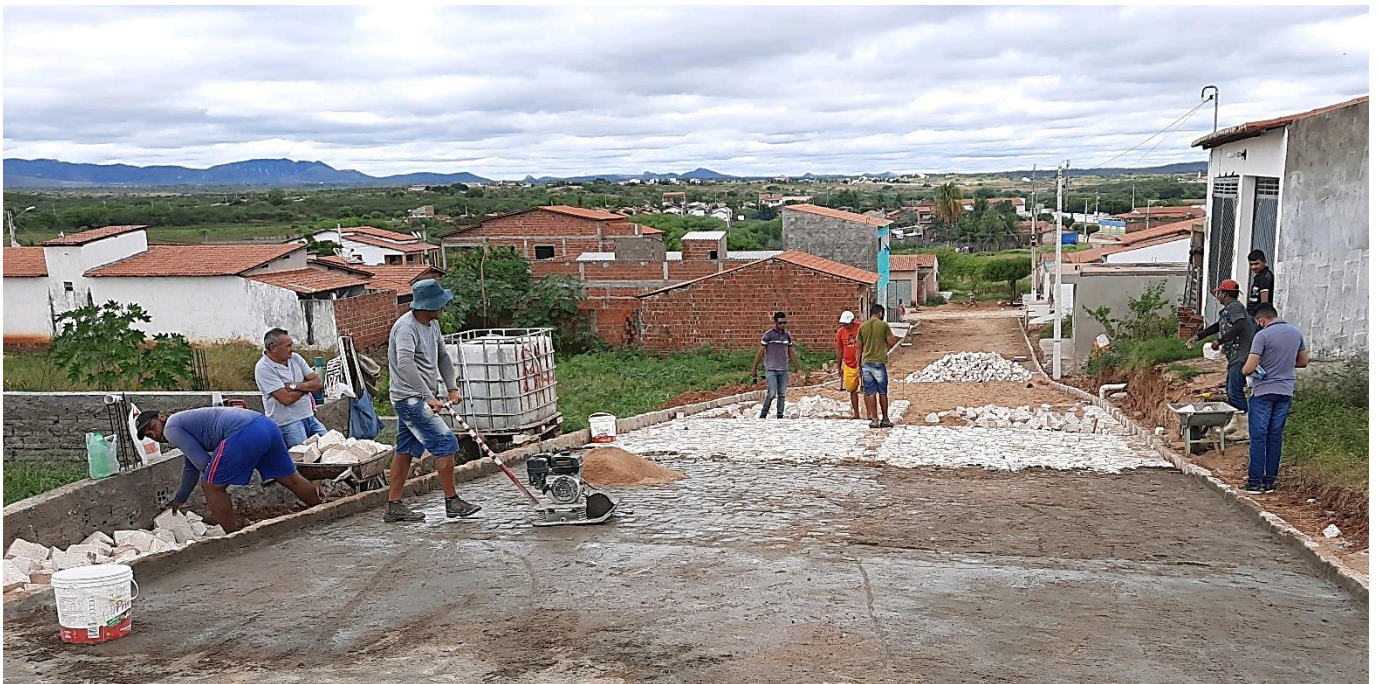
IMAGEM 06: COMPACTAÇÃO MANUAL DO PAVIMENTO
