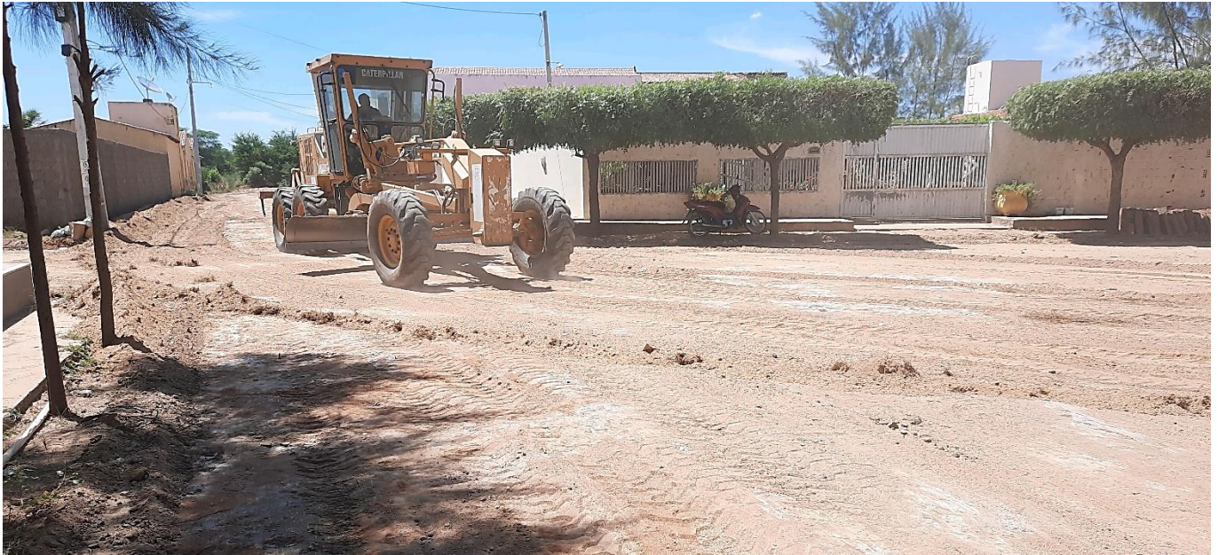
IMAGEM 03: EXECUÇÃO DA TERRAPLANAGEM DE RUA
