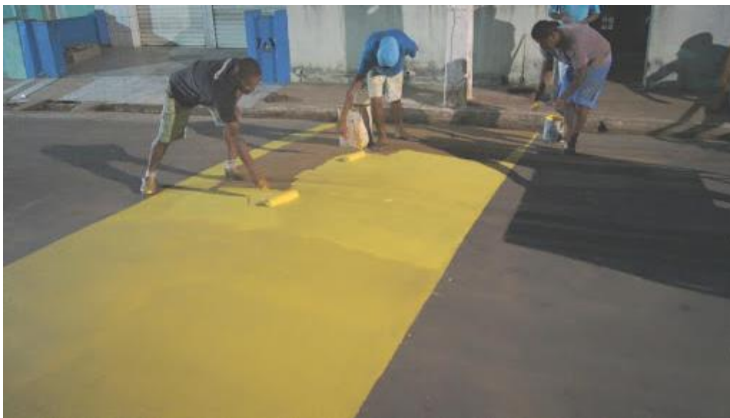
IMAGEM 09: PINTURA DE MEIO FIO.
