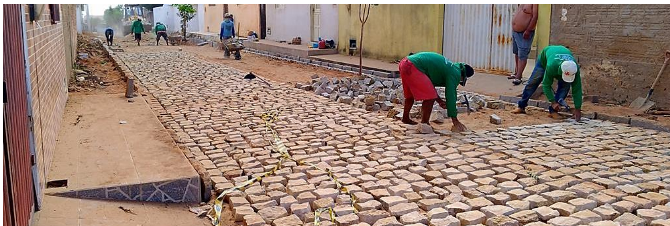
IMAGEM 04: ASSENTAMENTO DE PARALELEPÍPEDOS
