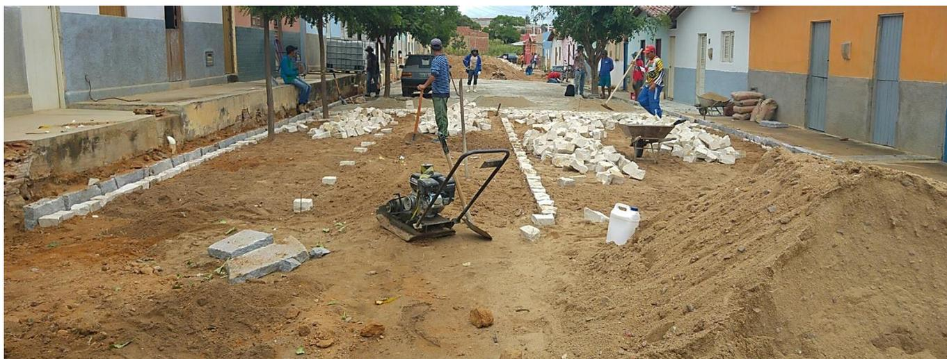
Sobre a camada de base do pavimento devidamente preparada, deverá ser esparramada uma camada de areia grossa em uma espessura tal que, somada à altura do paralelepípedo, perfaça um total de 10cm após a compressão.
