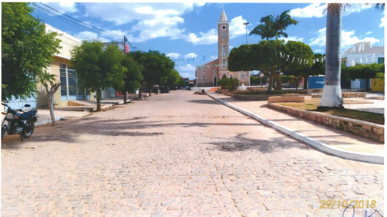
OBSERVAÇÃO: TRECHOS 01 E 02
