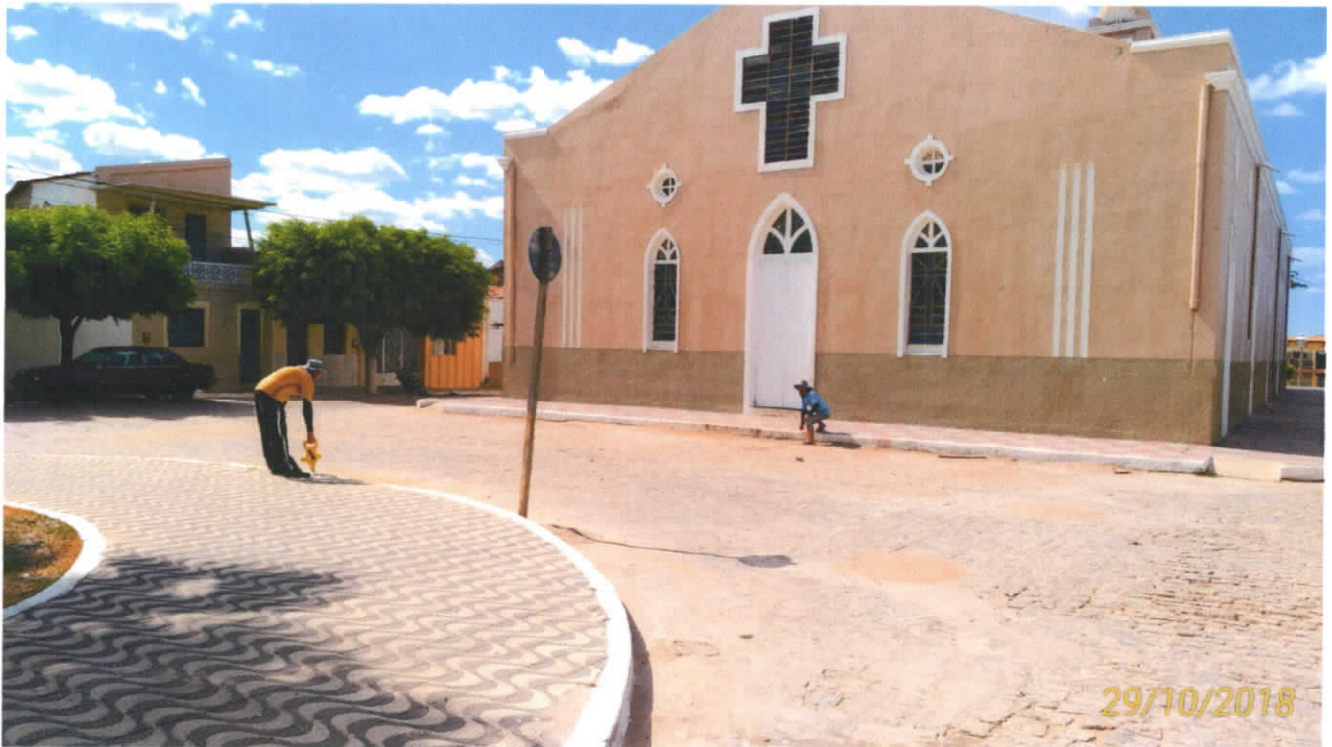
OBSERVAÇÃO: FUNDOS DA IGREJA CATÓLICA
