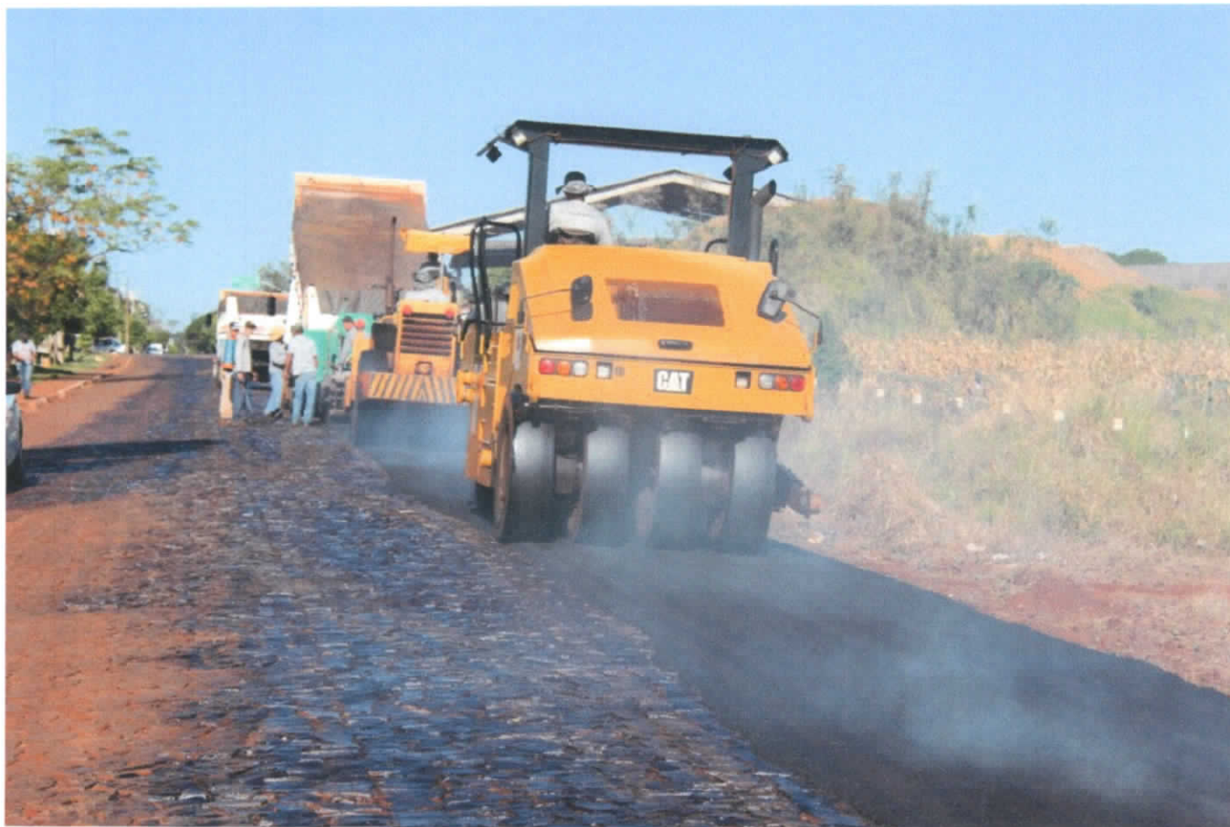
Imagem 03: Camada de regularização
